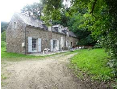
Moulin de Pont-ar-Keneut. Le canal d'aménée greffé sur le Saint-Laurent activait une meule toujours présente dans le bâtiment.
