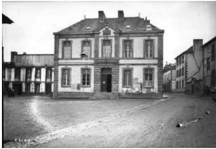
Concarneau, la mairie : [photographie de presse] / [Agence Rol]. 1913. Bibliothèque nationale de France, département Estampes et photographie, EST EI-13 (226)
