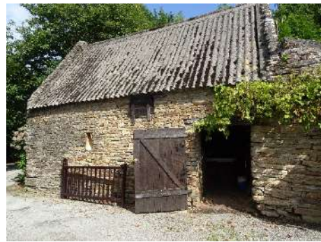
Lochrist. Ancienne cidrerie.
