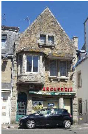
6, rue de la Gare. Maison à façade pignon néobretone. Vers 1920.
