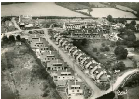
Le Dorlett en cours de construction. AC, 23 Fi 762.
