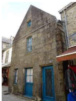
Ville-Close, 24, rue Vauban
