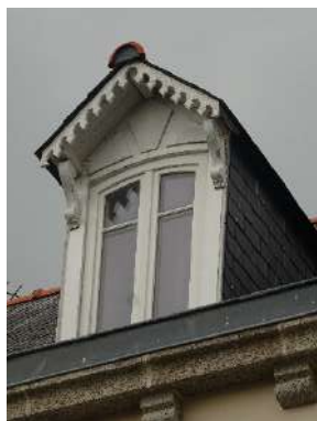
Rue Amiral Courbet. Lucarne en à jouées en bardage d'ardoises.
