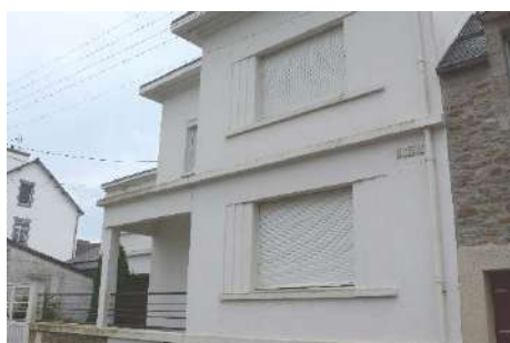
29, rue Lucien Hascoët. Jacques Deyrolle, architecte. Vers 1930 – 1940 ?
