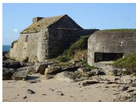
Le fort du Cabellou. Le corps de garde couvert en lauzes et le blockhaus érigé par les Allemands durant la Seconde Guerre mondiale.
