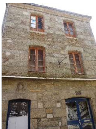
Ville-Close, 28, rue Vauban
