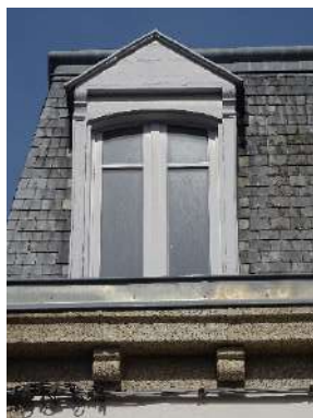
Ville-Close. Rue Vauban. Linteau en arc en arc segmentaire, pilastre et fronton triangulaire.
