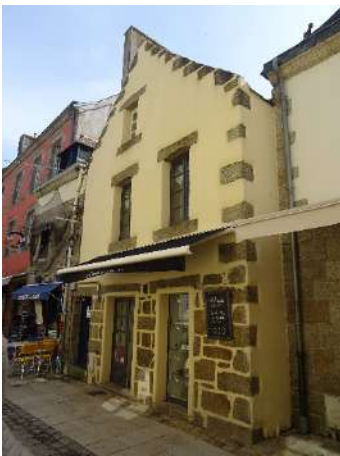
Ville-Close, 8, rue Vauban.
