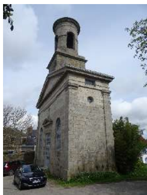
La façade et la tour de l'église Saint-Guénolé.
