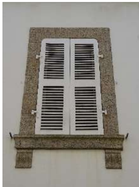
45, rue Jean Bart. Deux consoles supportent l'appui mouluré de la fenêtre.
