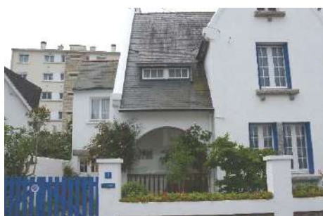
1, rue de la Libération. Jacques Deyrolle, architecte.
