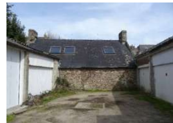
17, avenue Pierre Guéguin. Maison en cœur d'îlot. 17 e siècle ? Vue depuis la rue des Ecoles.
