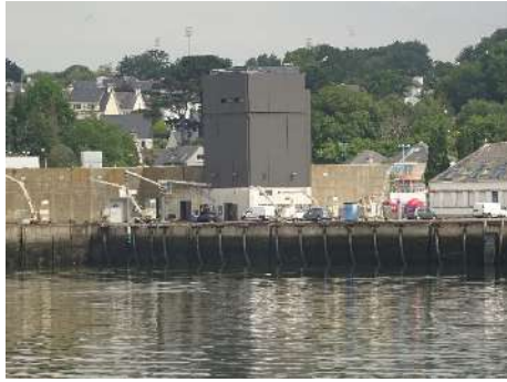
Le silo à glace construit en 2011.
