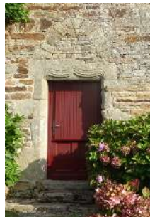
Porte sous linteau en arc en accolade. 17 e siècle. Maison à Kerliguet.
