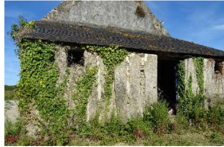
Petite dépendance (soue à cochon ?) adossée à une ferme. Entre les pierres debout, blocage en moellons.
