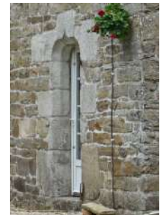
Porte chanfreinée sous arc déprimé clavé mouluré d'une accolade. 17 e siècle ? Maison rurale à Lanphily.
