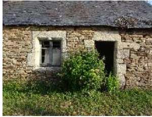
Fenêtre à croisée (seul reste le départ supérieur du meneau de pierre) et porte à encadrement rectangulaire à arêtes vives. 17 e siècle ? Petite maison élémentaire à La Haie.
