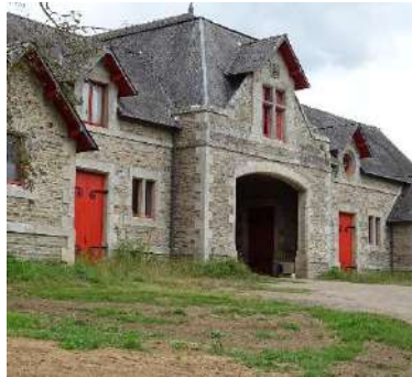
Les écuries du château de Lesnevar. Bâtiment néogothique à composition symétrique.
