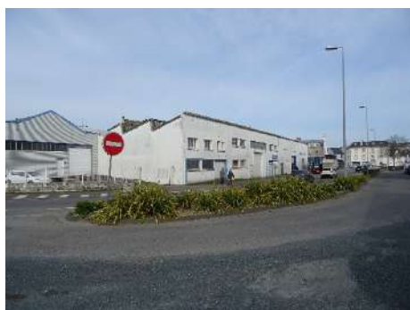
9, rue du Docteur Legendre. Angle avec le quai Carnot. Bâtiment industriel à sheds.
