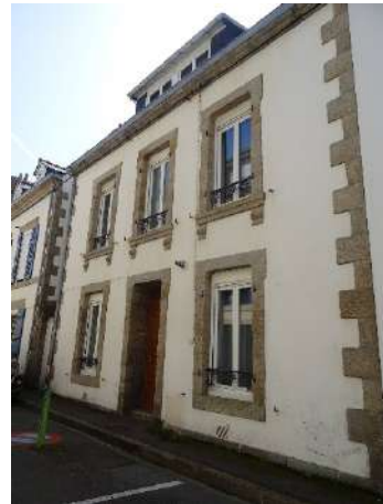
43, rue Jean Bart. Parement en maçonnerie moellonnée enduite. Encadrements de baies, chaînes d'angle et corniche en granite.
