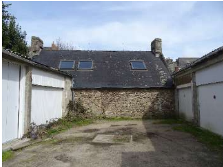
17, avenue Pierre Guéguin. Maison en cœur d'îlot. 17 e siècle ? Vue depuis la rue des Ecoles.
