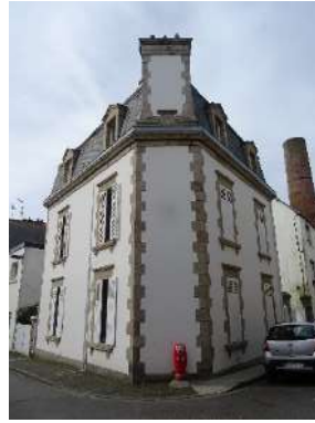
13, rue Bayard. Toiture à brisis et terrasson. 1904.
