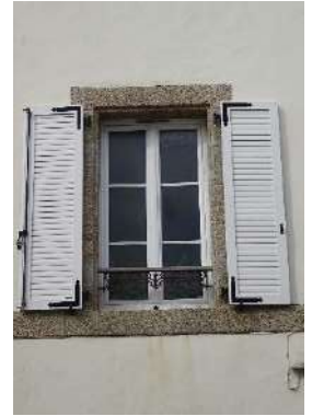
25, rue Bayard. Encadrement avec feuillure.
