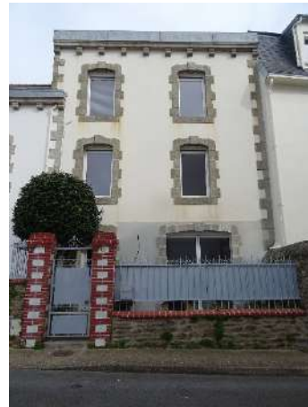
16, rue Général Morvan. Mur-bahut en moellons et grille en ferronnerie. Vers 1910.
