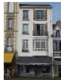
3, avenue Pierre Guéguin. Art déco. Bow-window en béton.
