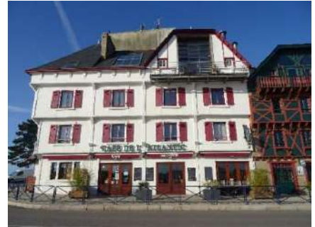
23, avenue du Docteur Pierre Nicolas. Façade néogothique en faux pan de bois. Béton armé.
