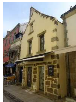
Ville-Close, 8, rue Vauban.
