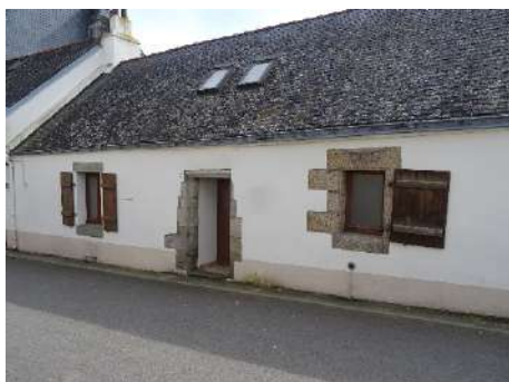
Maison, 9 rue de l'Alma. Ancien faubourg l'Aire l'Evêque.
