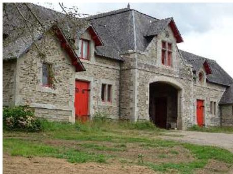
Les écuries du château de Lesnevar. Bâtiment néogothique à composition symétrique.
