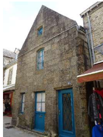
Ville-Close, 24, rue Vauban.
