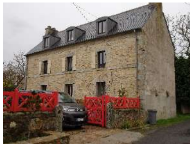
Kerlean. L'aspect des ouvertures de la façade à l'origine enduite se brouille dans le parement moellonné.
