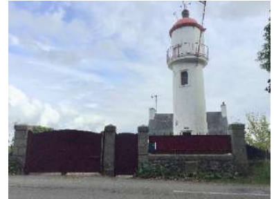
Phare de Kériolet, 1848 (entrepreneur : Raboisson). Phare hors service, remplacé par le phare du clocher de l'église de Beuzec. Dans l'alignement de la balise du Cochon et du phare de la Croix, il donnait l'axe du cheval d'entrée au port.
