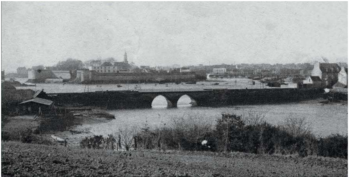
Le pont du Moros
