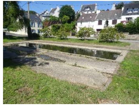
Le lavoir Saint-Jacques, rue des Chênes. Ne subsiste que le bassin bétonné.
