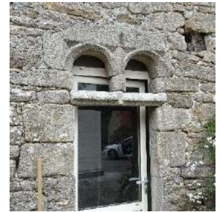
Fenêtre à meneau du 17 e siècle transformée en porte. Roz Bihan.
