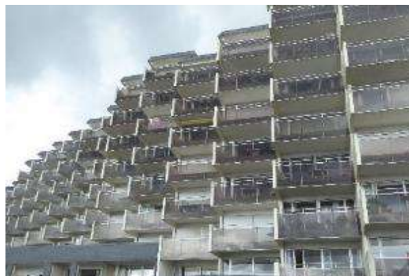
Immeubles à façade à balcon, hors d'échelle, Boulevard Bougainville, quartier Coat-Pin
