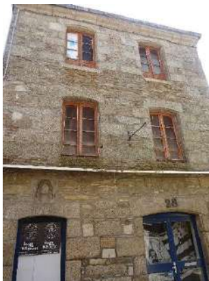
Ville-Close, 28, rue Vauban
