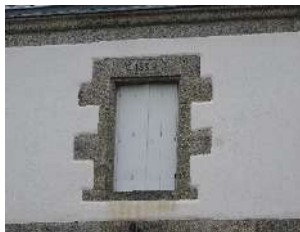
Fenêtre en granite daté de 1832. Maison à travées à Kerambrigan.
