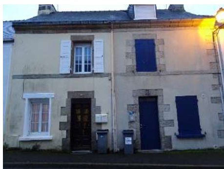
12 et 14, rue Jules Ferry (Le Passage). Maisons de « matelots » jumelles.
