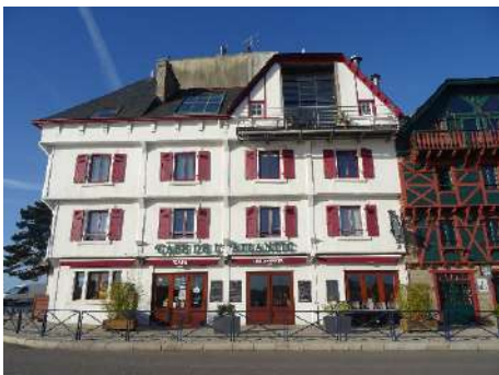
23, avenue du Docteur Pierre Nicolas. Façade néogothique en faux pan de bois. Béton armé.
