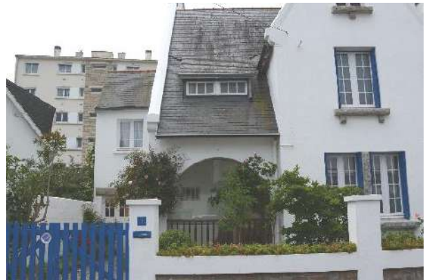
1, rue de la Libération. Jacques Deyrolle, architecte.
