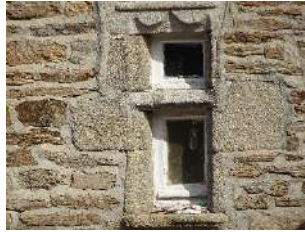
Fenêtre à traverse à linteau en arc en accolade. 17 e siècle. Petite maison à Kersaby.
