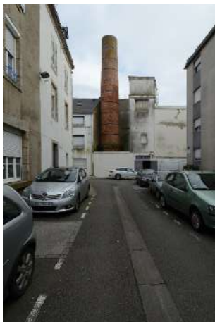
La cheminée de l'usine Bouvais-Flon.
