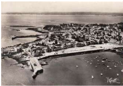
Le bassin Pénéroff après comblement.
