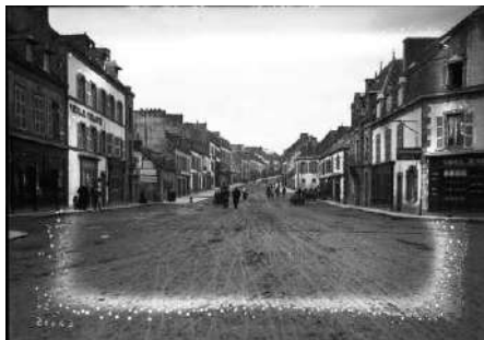
Concarneau. La rue centrale : [photographie de presse] / [Agence Rol]. 1913. Bibliothèque nationale de France, département Estampes et photographie. Actuelle avenue de la Gare.
