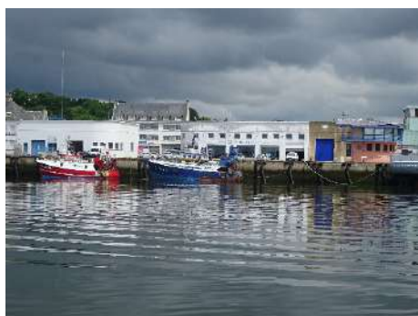
Le quai Est. L'îlot sud et la capitainerie.
