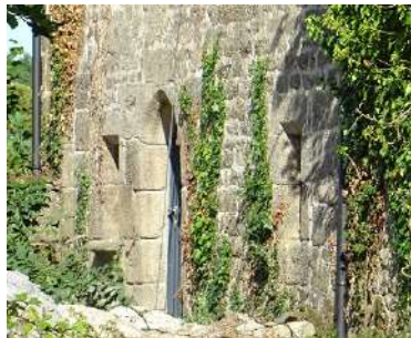
Porte en arc brisé et fenêtres chanfreinées. 17 e siècle ? Petite maison à Kerrichard.
