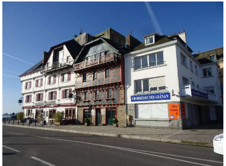
Avenue du Docteur Pierre Nicolas. La maison Guillou-Deyrolle est cantonnée par un immeuble des années 1960.
