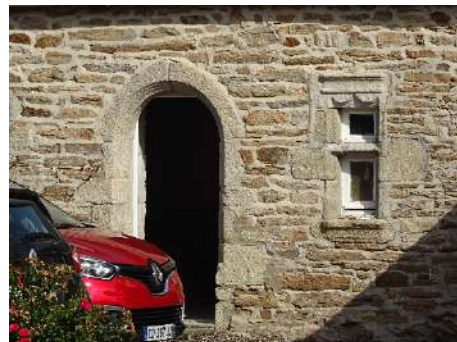
Kersaby. Détail sur la porte et la fenêtre à traverse et linteau orné d'un arc en accolade.
