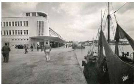
La criée construite en 1952.
