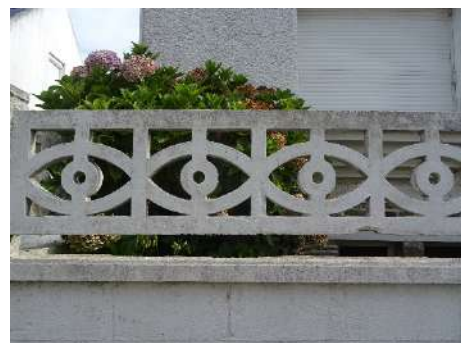
Le Passage. 4, rue Bisson. Mur-bahut à claire-voie en béton armé. Vers 1930-1940.
