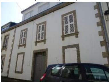
45 rue Jean Bart. Façade tripartite.
