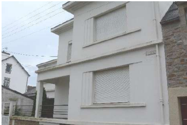
29, rue Lucien Hascoët. Jacques Deyrolle, architecte. Vers 1930 - 1940 ?
