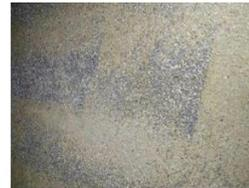
Lixiviation de la matrice cimentaire du revêtement d'imperméabilisation – Voile moyen et radier
