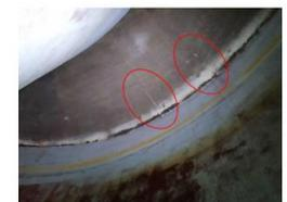
Fissures radiales avec traces de calcite – Intrados de coupole
