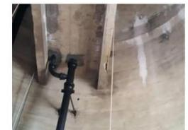
Epaufrures avec armatures apparentes corrodées – Palier sous face de cuve
