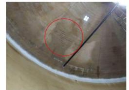
Epaufrures avec armatures apparentes corrodées – Intrados de coupole
