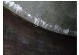
Epanchement de calcite au droit d'une reprise de bétonnage – Intrados de coupole
