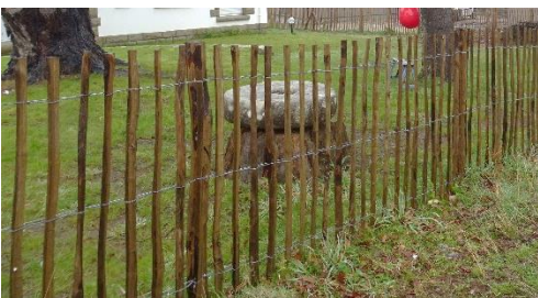
Clôture légère en fascines
