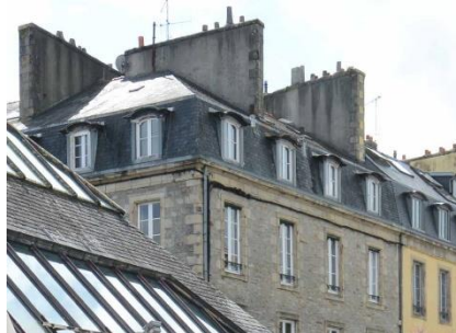
Lucarnes* en bois recouvert de zinc
