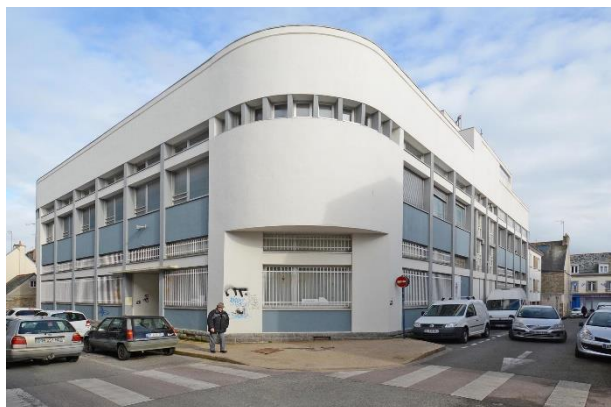
Télécommunication, rue Villebois-Marreuil
