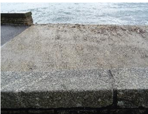
Béton strié ou pavages pour les rampes.
