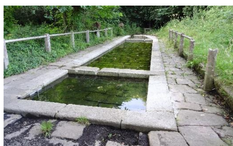
Le lavoir de Lanriec accessible par un chemin
