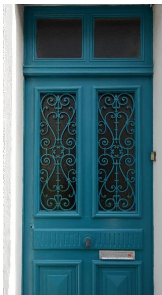
Porte avec plein jour vitré et protégées par une ferronnerie en acier ou en fonte
