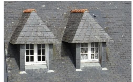
Lucarne* bois sur charpente à 3 versants
