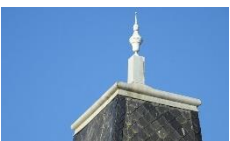
Épis* de toiture
