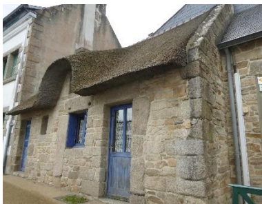
Toiture en chaume à Lanriec
