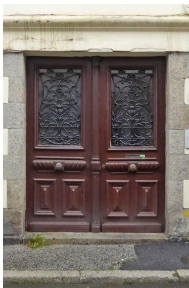
Porte avec plein jour vitré et protégées par une ferronnerie en acier ou en fonte
