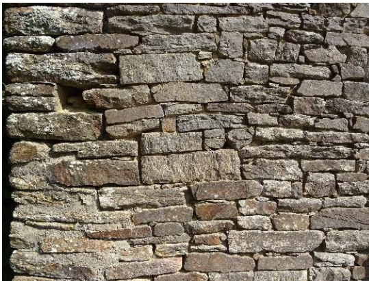
Parement de mur en moellons* de micaschiste. Lochrist.
