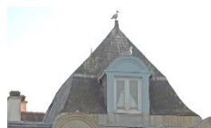
Épis* de toiture
