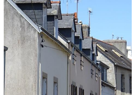
Lucarne* bois sur charpente à 2 versants
