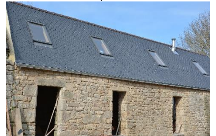
Châssis de toiture inscrits dans l'épaisseur du toit
