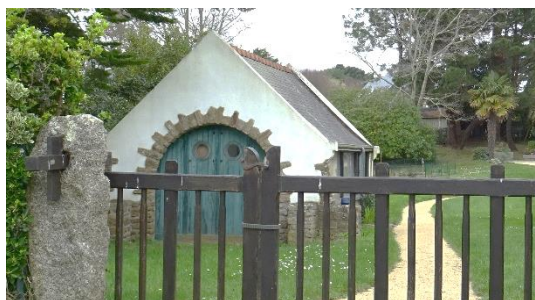
Annexe néo-bretonne, proche d'une limite séparative
