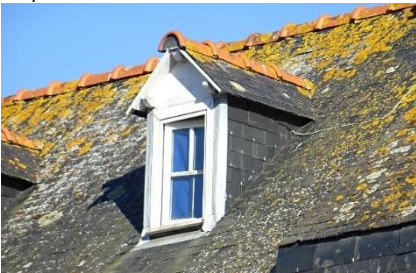
Lucarne* bois sur charpente à 2 versants
