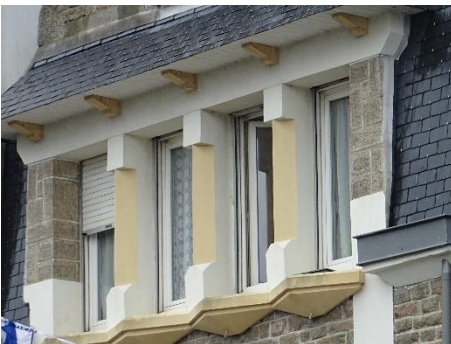
A partir du milieu du début du 20 ème siècle des baies sont créées avec des volets roulants intégrés. Dans ce cas l'enrouleur est à l'intérieur, notamment sur des villas balnéaires.
