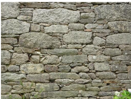
Grange. Parement de mur en moellons* de granite. Le Mégot.
