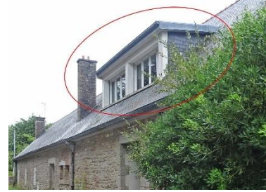
Le « chien assis* », prohibé sur le bâti ancien protégé
