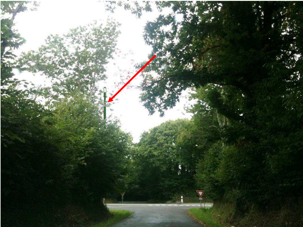
Vue après l'installation
