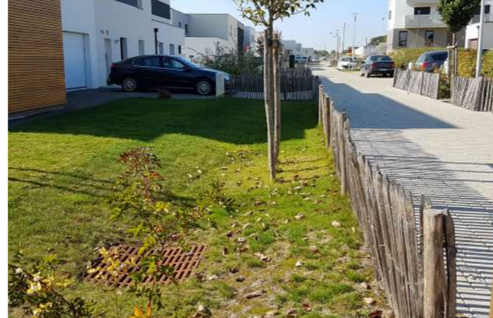
Gestion eaux pluviales : Noues
