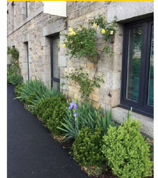
Pieds de façades végétalisés
