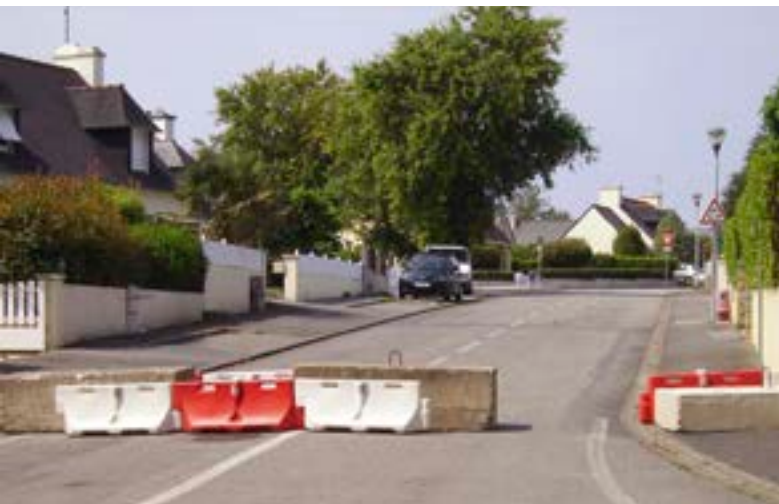
Le barrage provisoire de la rue de l'Odet.
