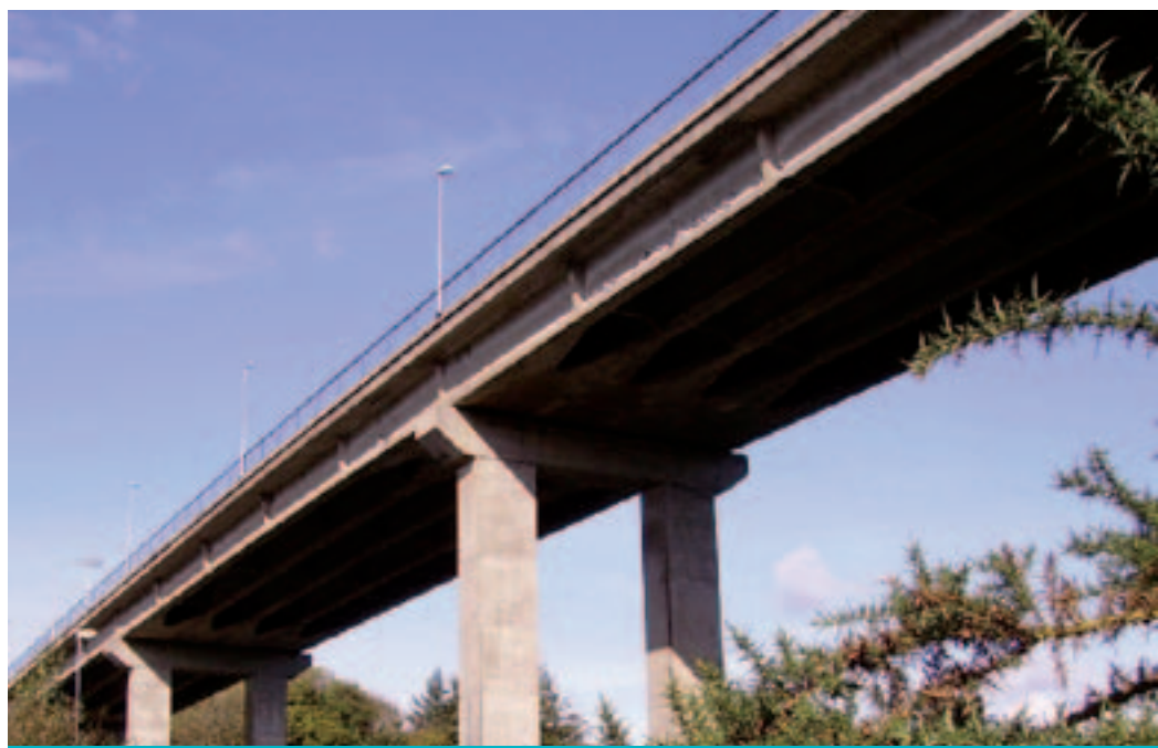
L'ouvrage actuel, construit en amont de la rivière
