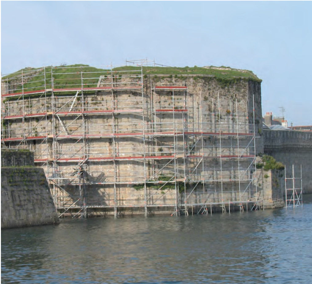
Les travaux d'étanchéité de la tour du Gouverneur en cours.
