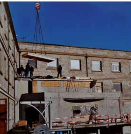
Construction, en 2001, du grand aquarium au-dessus des viviers du Laboratoire de biologie marine.
