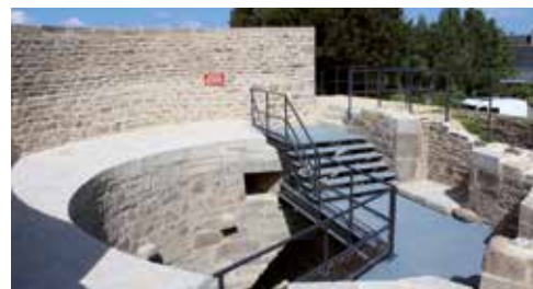
L'aménagement d'une passerelle a permis d'assurer la continuité piétonne entre la tour du Gouverneur et la tour du Passage.
