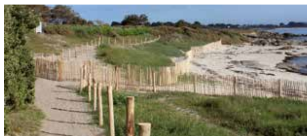
Sentier côtier plage des Bouchers : installation de ganivelles et plantation d'oyats pour une protection renforcée de la dune.
