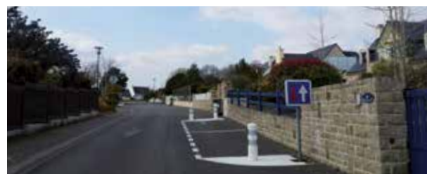
Rue des Pervenches : réalisation de rétrécissements et matérialisation de stationnements pour une circulation sécurisée.
