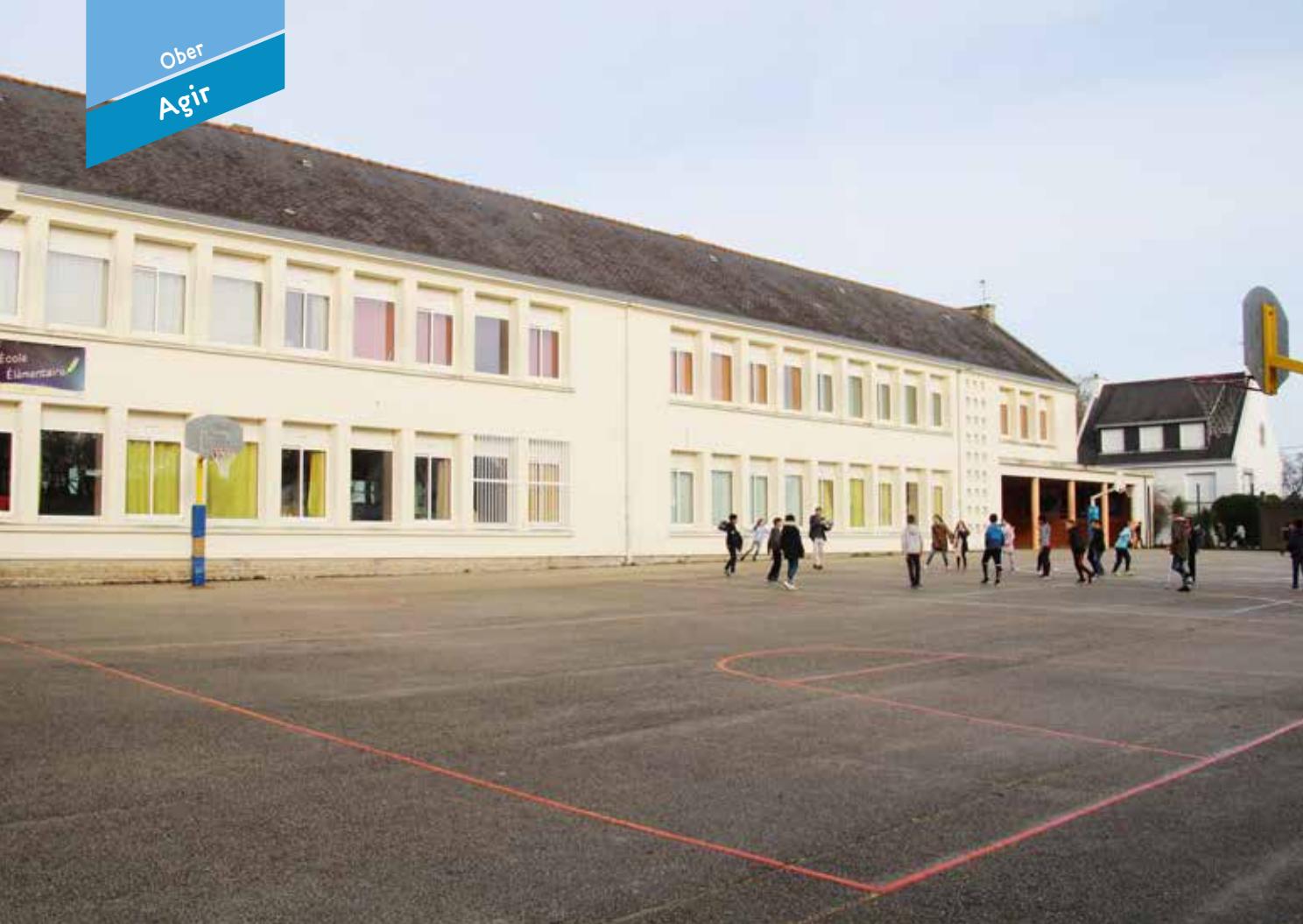
Le groupe scolaire du Rouz (1 36 élèves) bénéficiera d'importants travaux de rénovation au cours des trois prochaines années.
