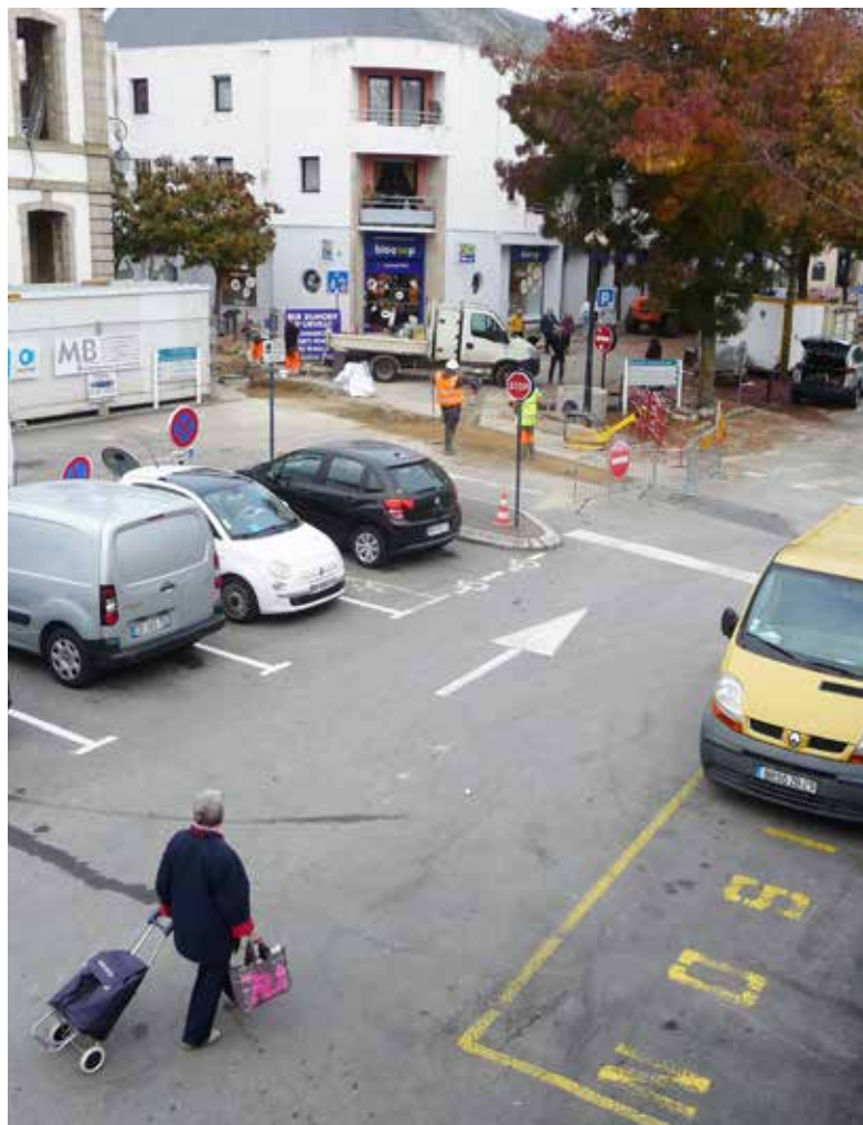
Les premiers travaux ont débuté à l'automne avec la reprise des réseaux d'eau potable, d'eau pluviale et d'eaux usées.
